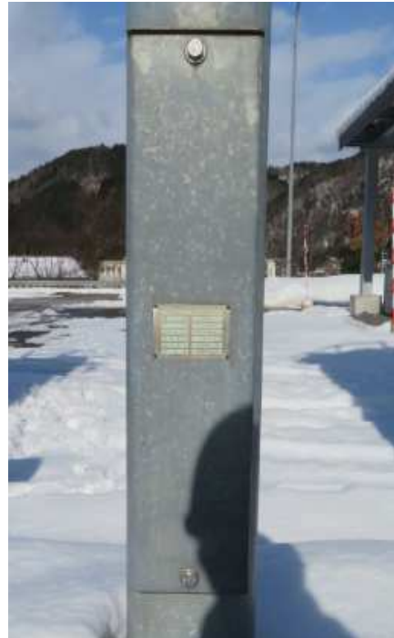
写真1. 照明柱点検口
