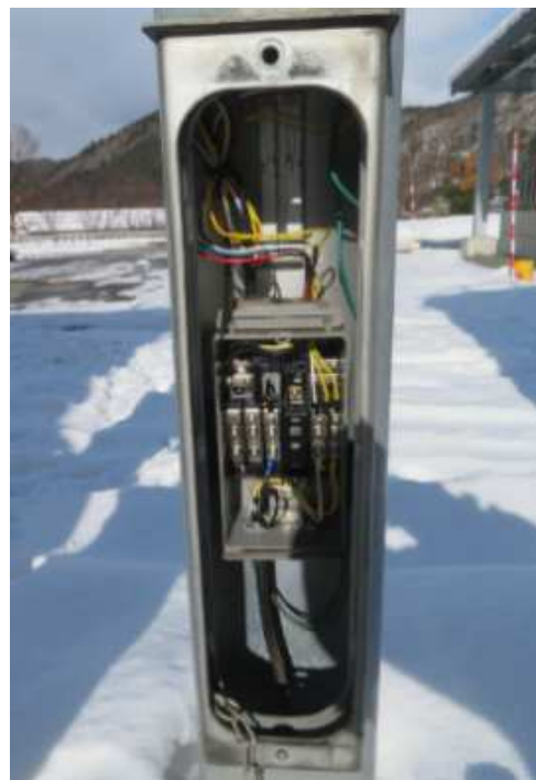
写真2. 照明柱点検口開放
