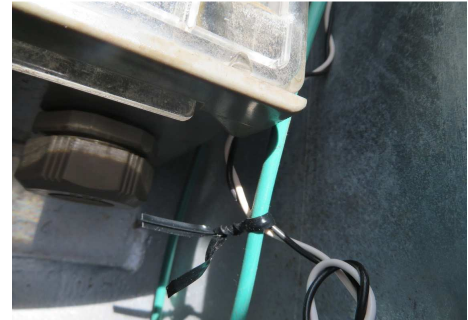
写真10. ビニルタイ施工
